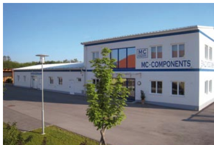
Das MC-COMPONENTS Gebäude.
